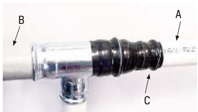
Рис. 39. Материалы для защиты от внешней коррозии: А. Труба с защитой из полипропилена; В. Покраска праймером; С. Защита бутаноловой клейкой лентой.
