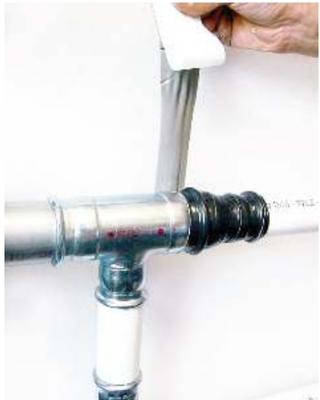
Рис. 38. Защита соединений с помощью бутаноловой клейкой ленты.
